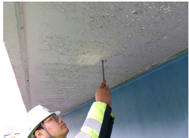
탄산화깊이 측정 현황
